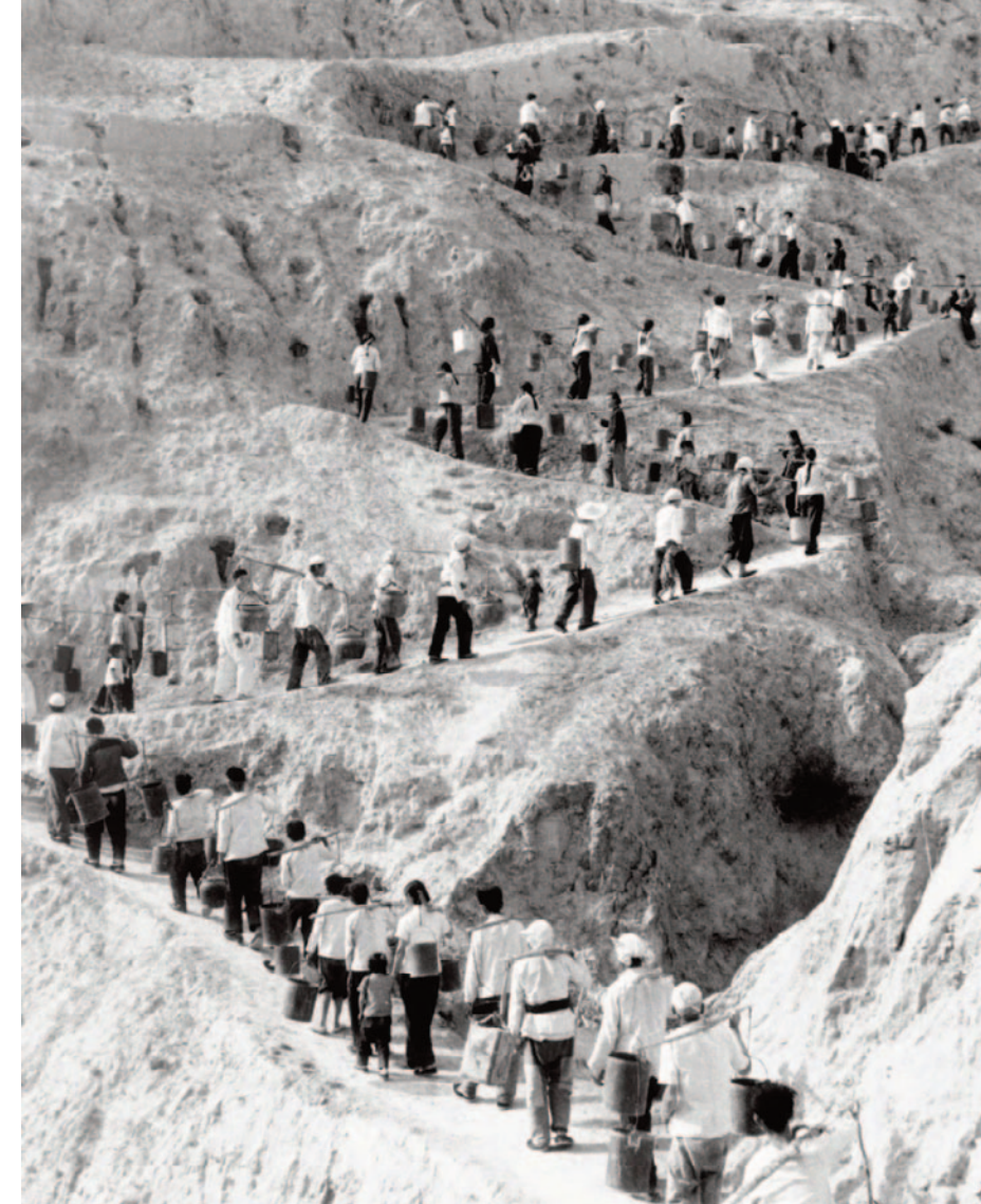
Nel 1972, a Houjialing, nella contea di Linxian, nella provincia dello Shanxi, lavoratori scalano montagne e colline per trasportare acqua e combattere la siccità. Foto: FOTOF 1972年，山西临县侯家岭，社员翻山爬坡挑水抗旱。图：FOTOF
