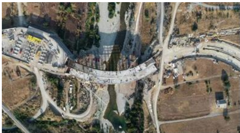
南北高速公路项目
